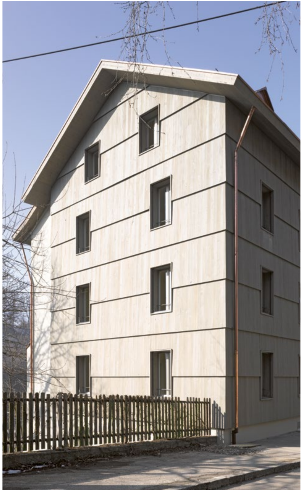
Lorraine: An der Jurastrasse werden vier Häuser geamtsaniert, aus Kleinwohnungen mit sehr tiefem Standard – keine Zentralheizung, nur eine Gemeinschaftsdusche im Keller – werden Wohnungen mit eigener Dusche/WC und zeitgemässer Küche im Segment «Günstiger Wohnraum».
