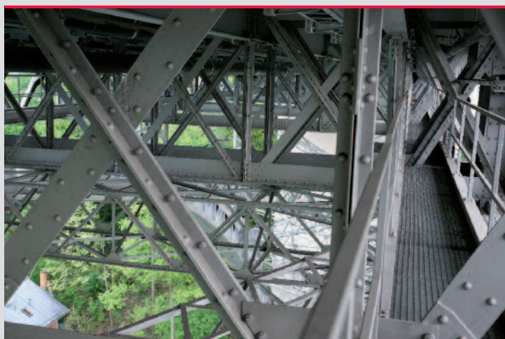
Gut festhalten und Kopf einziehen: der enge Servicesteg (rechts im Bild) mitten in der Brückenkonstruktion.
