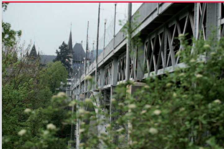
Der Begehungsort liegt direkt unter der Fahrbahn der Kirchenfeldbrücke.
