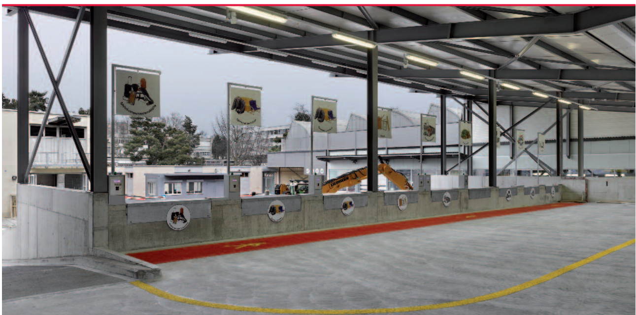
Das Herzstück der neuen Anlage: Im Rampengebäude können die Kundinnen und Kunden ihren Abfall sortengerecht selber entsorgen.
