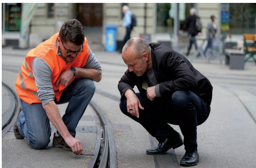
Tramschienen für die Radprofis abdecken: Patrik Gräppi (links) in der Variantendiskussion mit Martin Lehmann, Fachspezialist Kommunikation Tiefbauamt.
