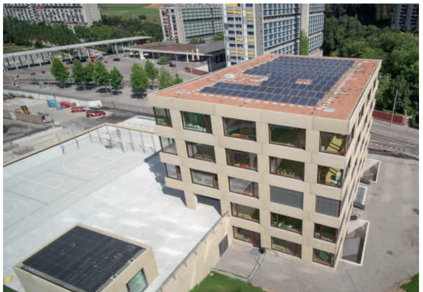
Photovoltaikanlage von Energie Wasser Bern auf dem Dach der Volksschule Brünnen am Billeweg 5.
