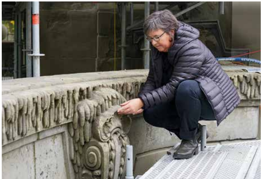
Prüft das Ausmass der Verwitterung am Sandstein: Barbara Beyeler.
