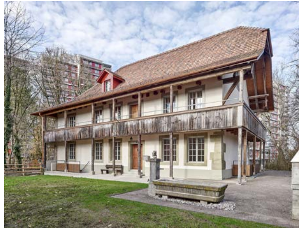
Aussenansicht Saalstock. Bild: Denkmalpflege Stadt Bern, 2020.
