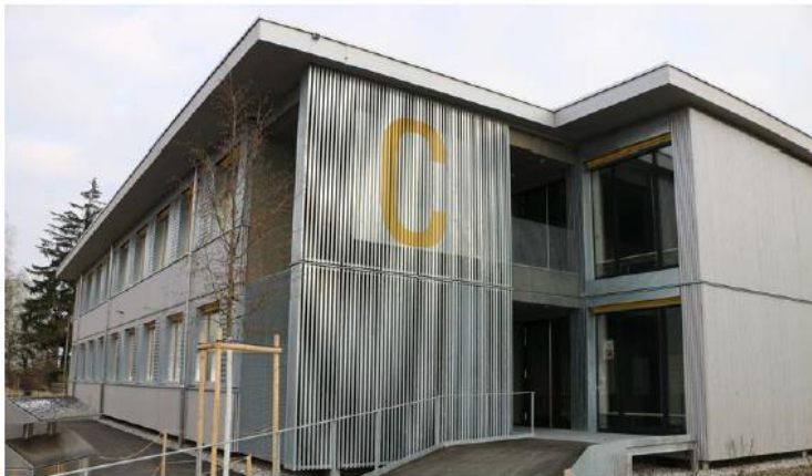
Aussentreppe Pavillon C
