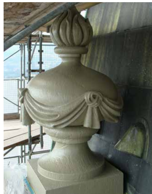
Vase nach Sanierung
