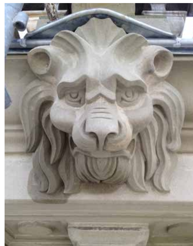
Löwenkopf nach Sanierung
