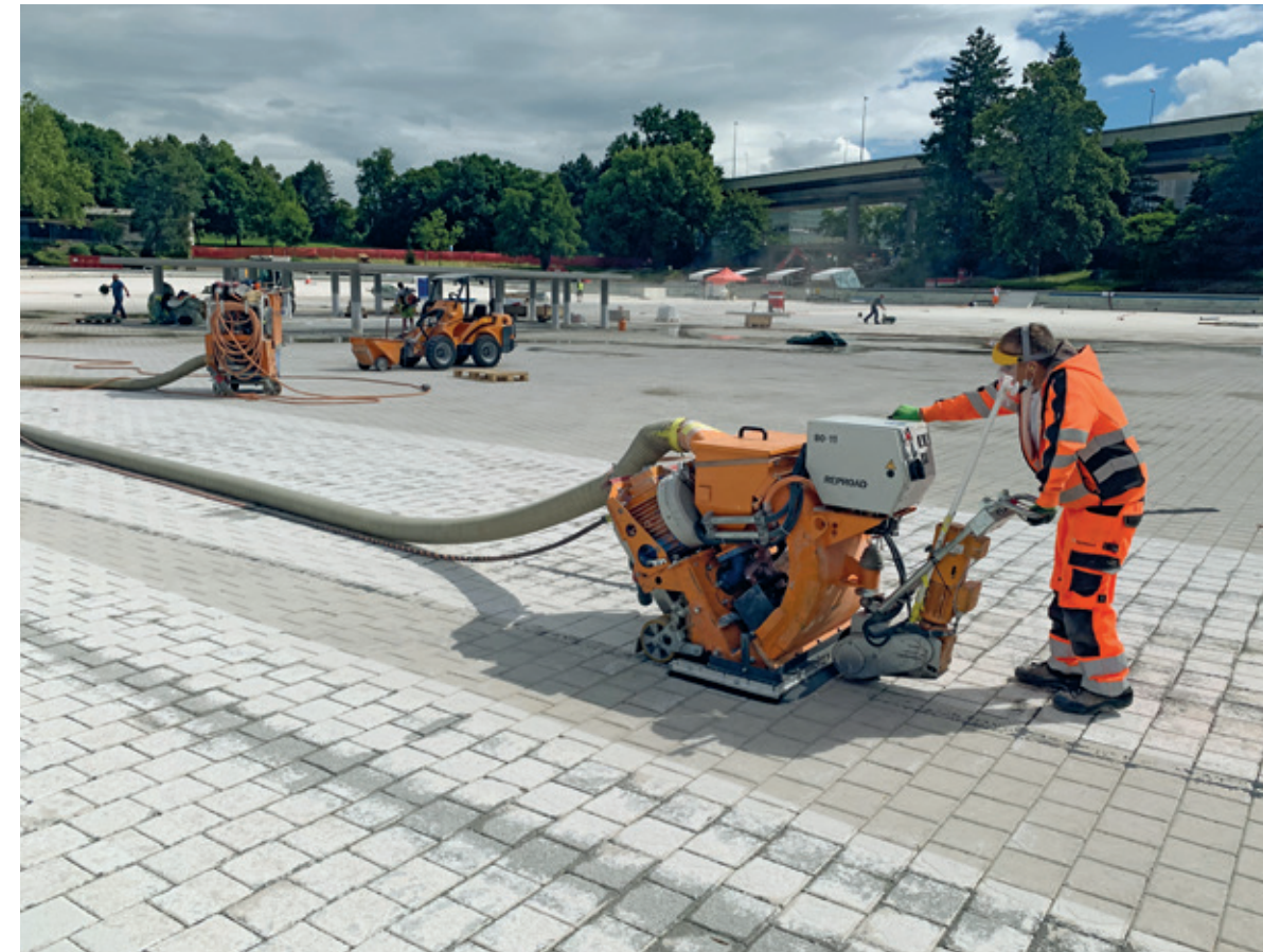
Baustelle Freibad Weyermannshaus
