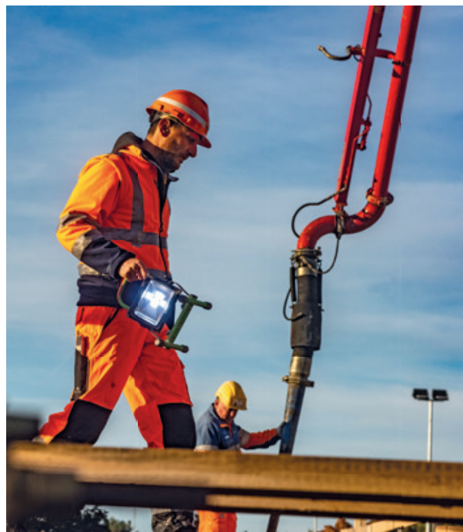
Die Koordination des Bauablaufs war das A und O.
