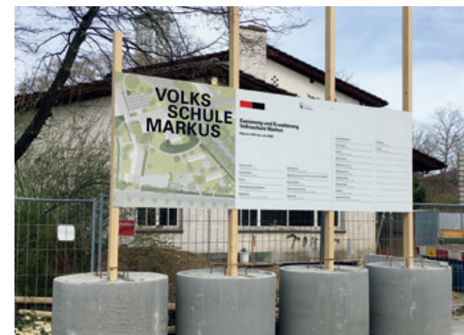
Baustellentafel Volksschule Markus
