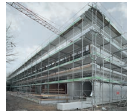
Baustelle Volksschule Stapfenacker
