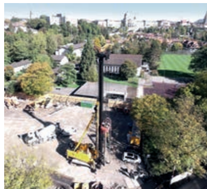
Baustart Volksschule Marzili
