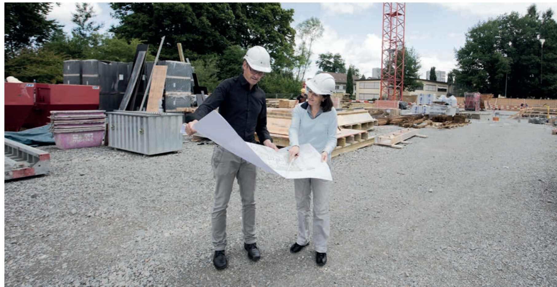
Mitarbeitende von Hochbau Stadt Bern überprüfen vor Ort den Bauteilzustand
