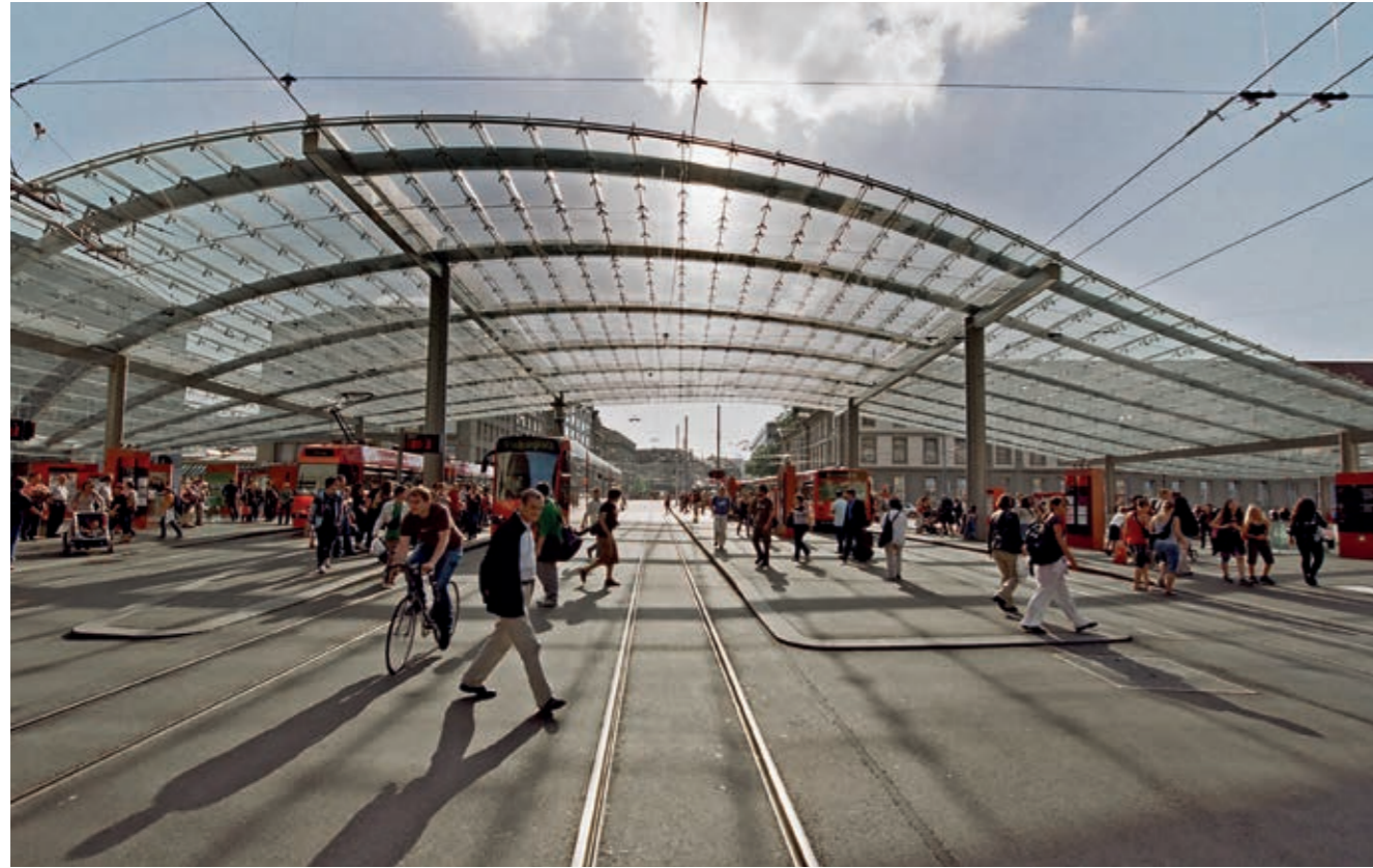
Wird regelmässig überprüft: Baldachin beim Bahnhof Bern
