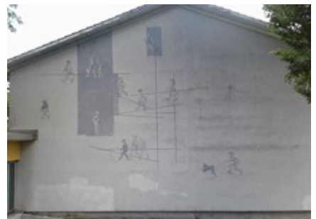
Kunst und Bau-Projekt Toni Grieb Foto: Jürg Omlin
