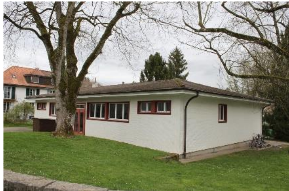
Schulpavillon II an der Forrerstrasse 3
