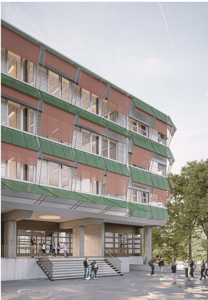
Fassaden- und Gebäudeausschnitt Fellerstrasse 18
