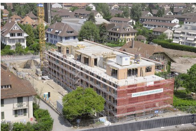
Das erste Gebäude der Siedlung Burgunder ist im Bau
