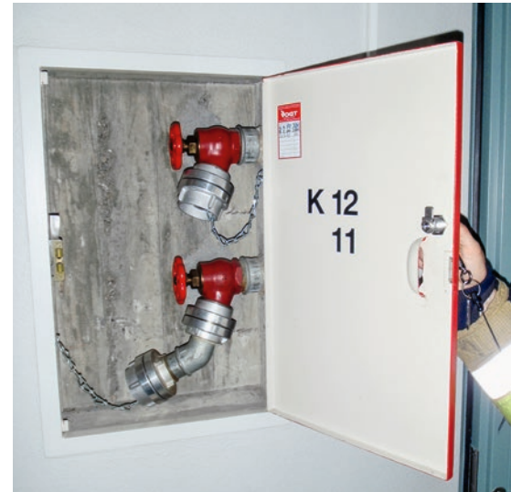
Einspeisung der Trockensteigleitung.
