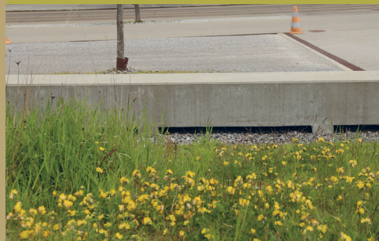
Beim Bau errichteter Kleintierdurchlass, Westside.
