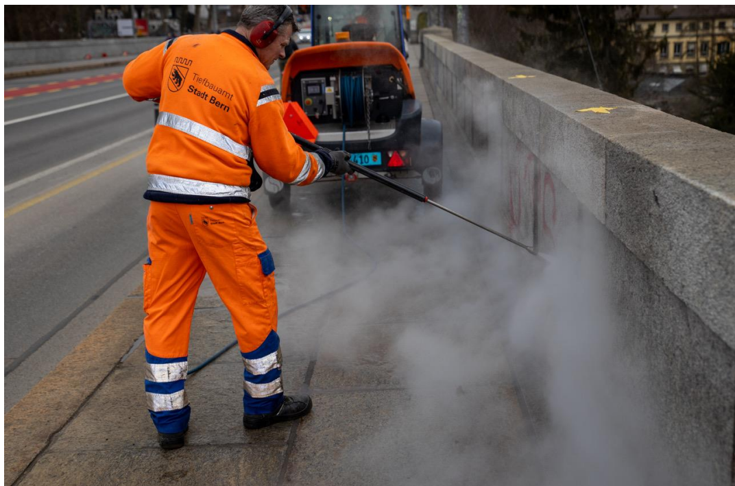
Graffitentfernung mittels Hochdruckreiniger (Foto: Matthias Lemke, Strassenreinigung)
