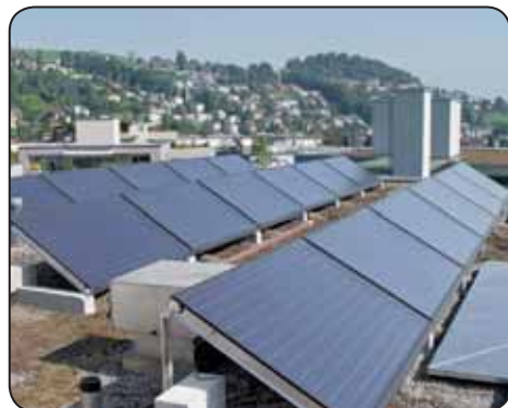
Sonnenkollektoren aufgeständert
