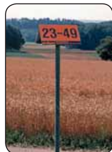
Markierung für Erdgasleitung
