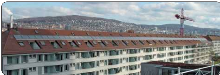
Sonnenkollektoren auf Mehrfamilienhäusern
