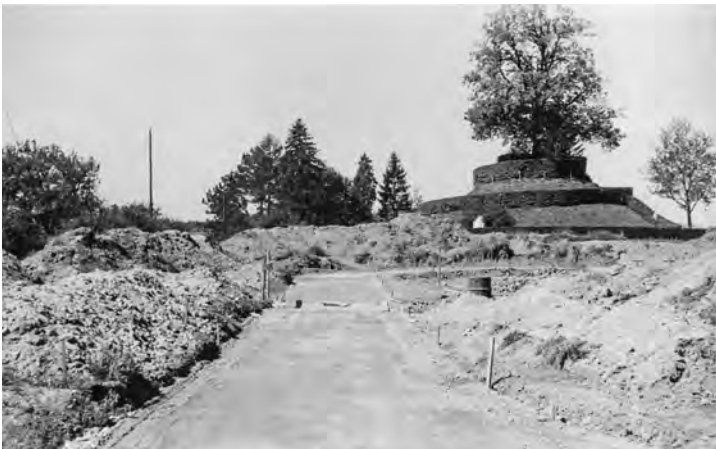
Bauarbeiten im Rahmen der Friedhofserweiterung, 1950
