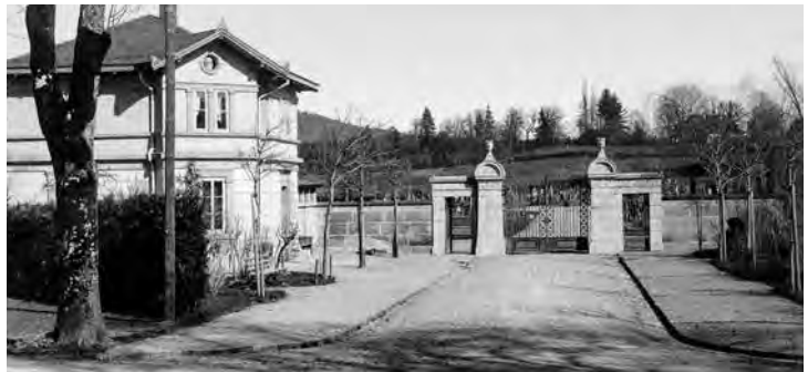
Pförtnerhaus und Eingangstor, zwischen 1879 und 1887
