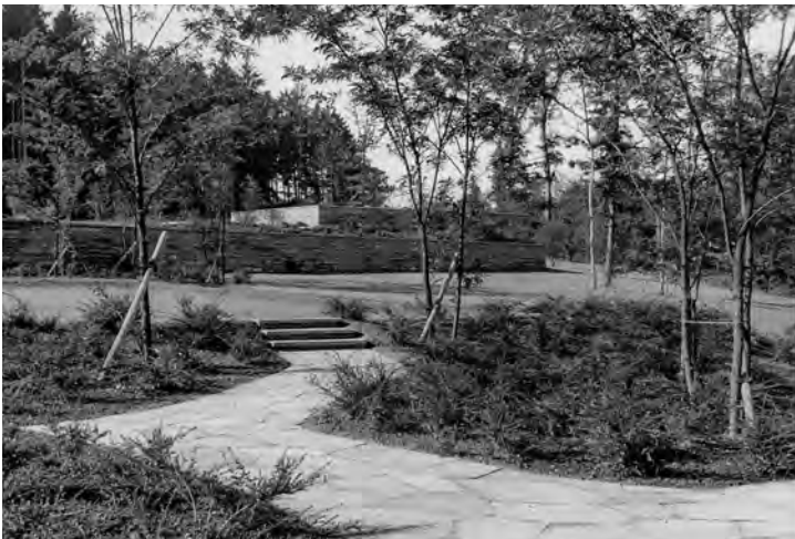
Die fertige Anlage, 1953/54
