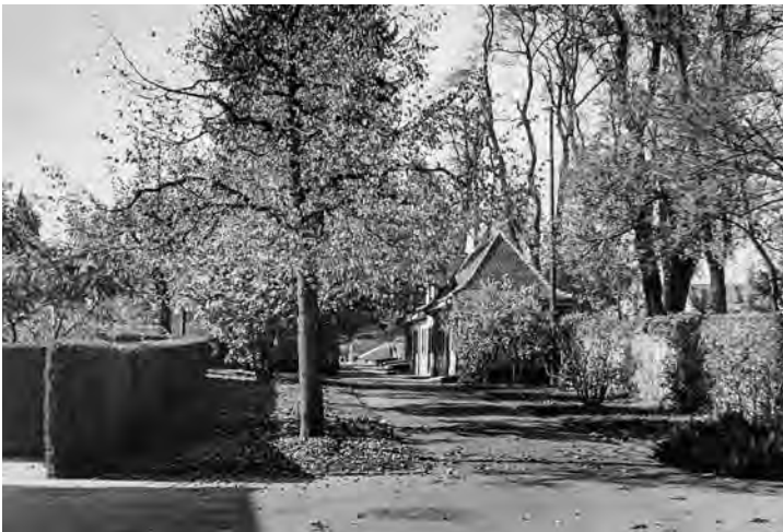
Materialschuppen an der Friedhofsmauer, 1953
