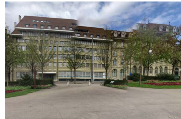
Eingang zur Kleinen Schanze vom Park aus gesehen (Quelle: google maps)
