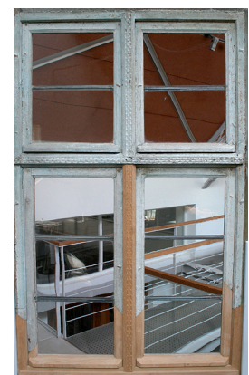
Restaurierte Fenster mit partiellem Holzersatz. Die historischen Beschläge wurden übernommen. Bilder: Hermann Klos.
