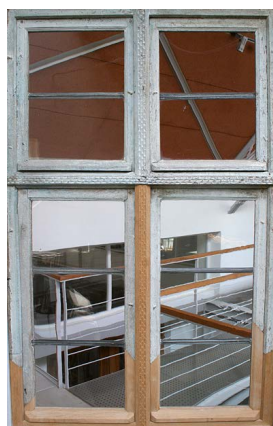
Restaurierte Fenster mit partiellem Holzersatz. Die historischen Beschläge wurden übernommen. Bilder: Hermann Klos.
