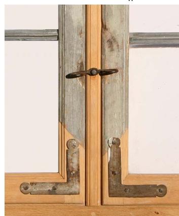
Restaurierte Fenster mit partiellem Holzersatz. Die historischen Beschläge wurden übernommen. Bilder: Hermann Klos.
