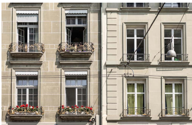
Links gestalterisch stimmige Sprossenfenster – rechts ein Fenstertyp ohne Sprossen, der das Fassadenbild sichtbar schwächt. Bild: Simon Opladen
