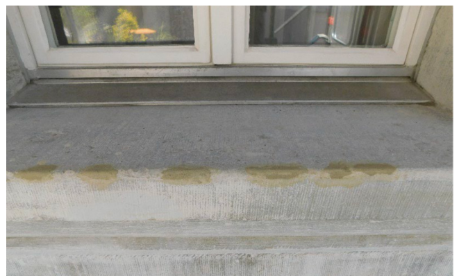
Abb. 05 – Flickarbeiten mit Sandstein-Mörtel, Fenstersims Foto: Fischer & Partner AG Restauratoren
