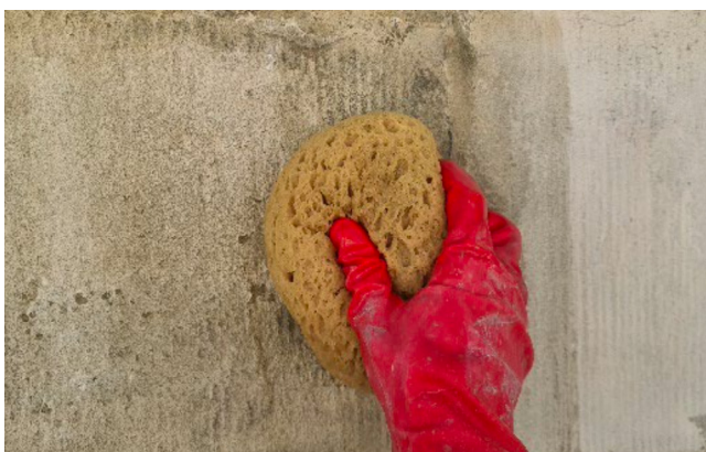
Abb. 04 – Verseifungsvorgang des alten Ölanstrichs mit Salmiak Foto: Fischer & Partner AG Restauratoren
