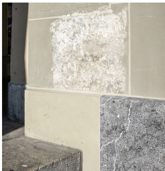
Abb. 02 – Rathausgasse 61, Bern. Unterschiedliche Oberflächen und Texturen machen historische Veränderungen im Naturstein ablesbar. Foto: Simon Opladen
