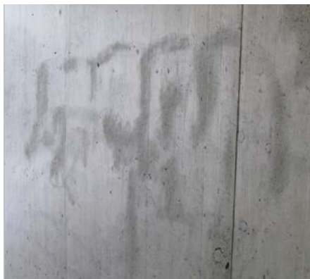
Mögliches Schadensbild nach einer Reinigung ohne präventiven Graffitienschutz
