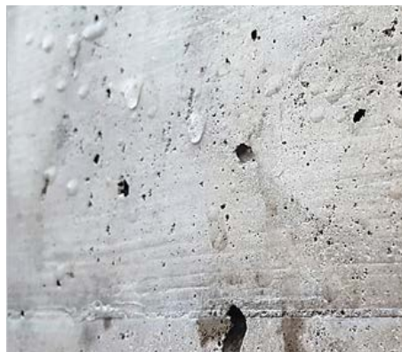
Beispiel einer transparenten Schutzapplikation auf Sichtbeton: Feuchtigkeit perlt ab
