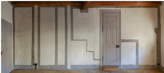
Abb. 01 – Vorbereitete Verbindung in Brandmauer zu Theaterplatz 1 Foto: Alexander Gempeler
