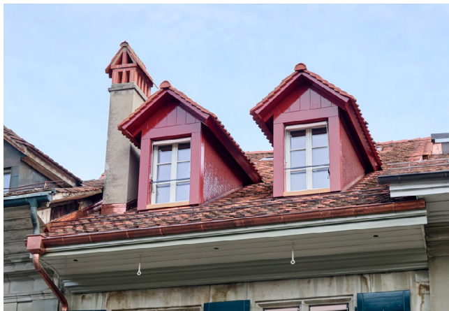
Abb. 02 - Lukarnen an der Junkerngasse, Foto: Simon Opladen
