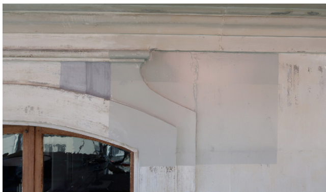
Abb. 03 – Muster für eine Neubeschichtung der Fassadenflächen mit einer halbdeckenden Ölfarbenlasur. Foto: Fischer & Partner AG Restauratoren
