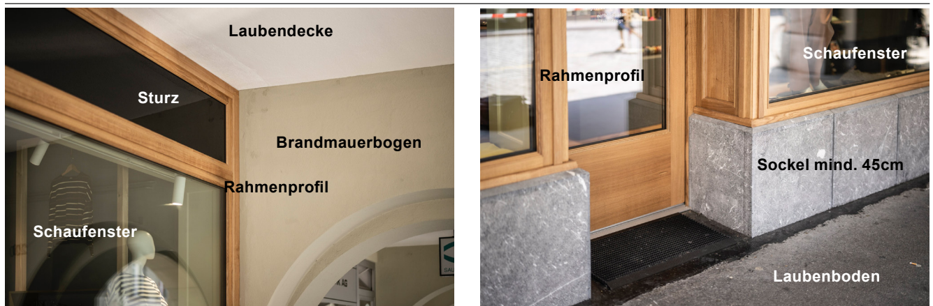
Abb. 03 und 04 – Wiederherstellung Schaufensteranlage, Kramgasse 20. Foto: Simon Opladen
