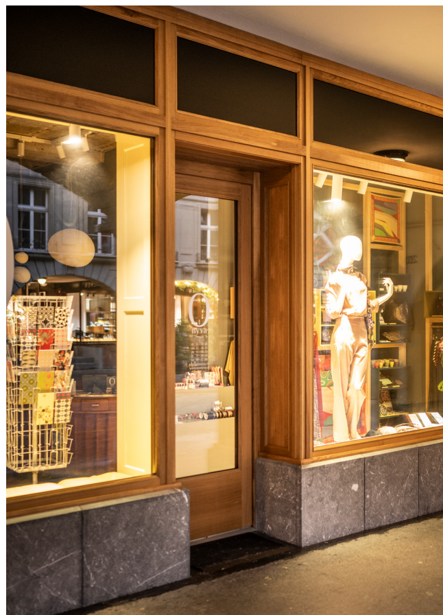
Abb. 02 – Wiederherstellung Schaufensteranlage Kramgasse 20. Foto: Simon Opladen
