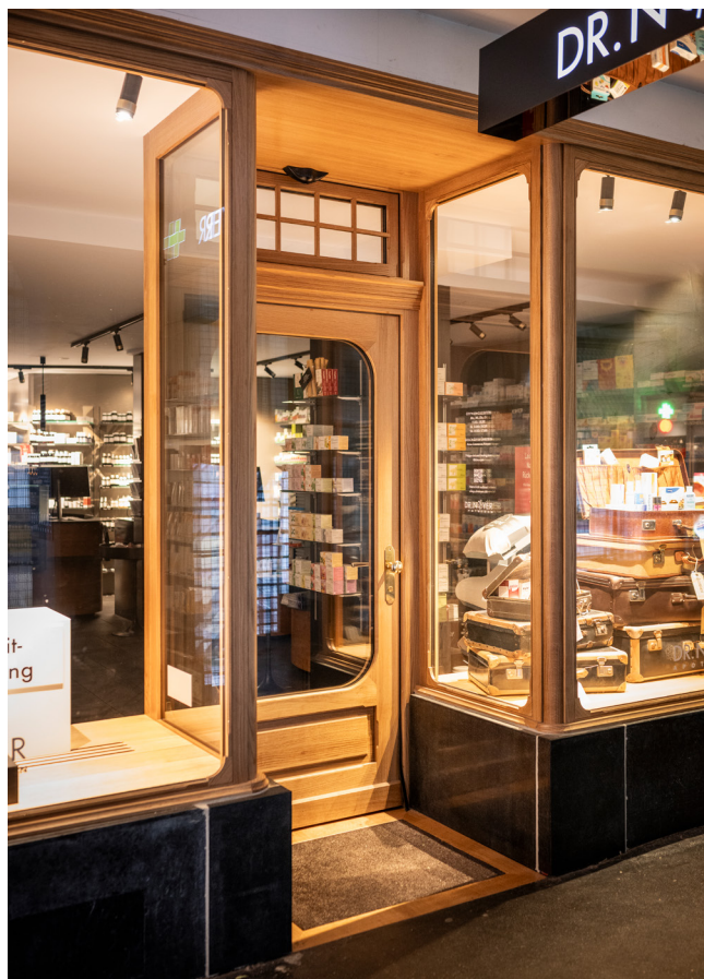
Abb. 01 – Wiederherstellung Schaufensteranlage Schuplatzgasse 7. Foto: Simon Opladen
