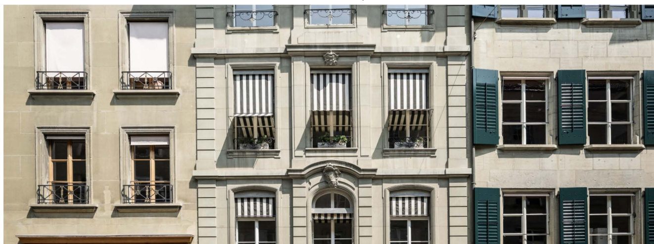
Abb. 01 – Vielfalt an Sonnenschutzlösungen: Senkrechtmarkisen, Fallarmmarkisen (Markisioletten) und klassische Fensterläden. Foto: Simon Opladen
