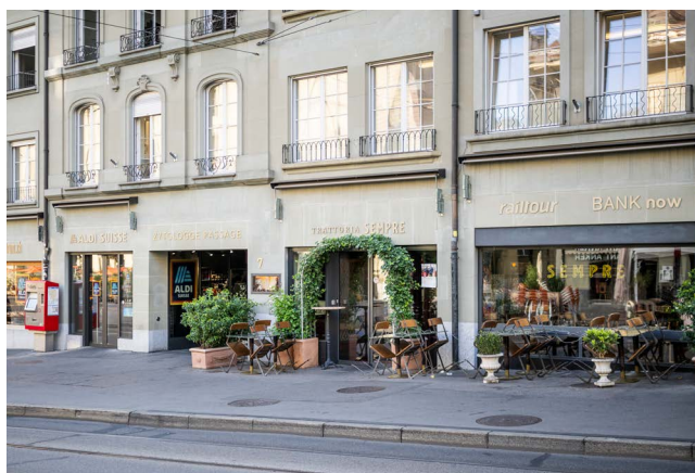
Abb. 05 – Unbeleuchtete Flachschriften an Fassade
