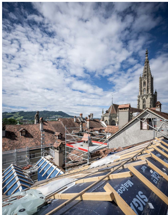
Abb. 01 – Dämmung des Hauptdachs. Foto: Simon Opladen
