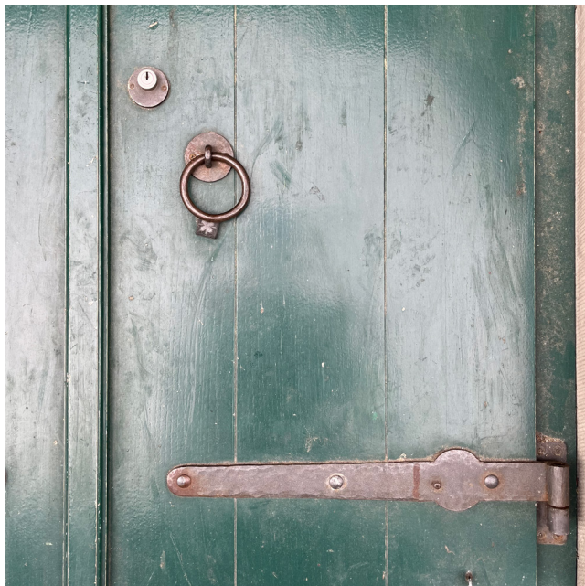
Abb. 03 – Kellertor an der Kramgasse 13. Langband, Klopfer und Schlüsselloch mit Rosette. Foto: Generalplanerteam
