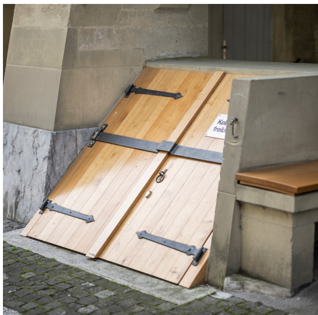
Abb. 02 – Kellertor in Eiche naturgeölt an der Junkerngasse 49. Foto: Simon Opladen
