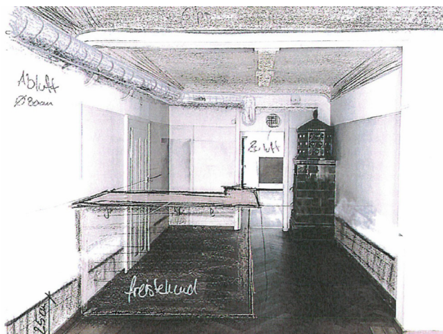
Abb. 03 – Aufzeigen von Lüftungsinstallationen im Innenraum an der Kramgasse 28: So dargestellt werden die Auswirkung am Objekt sichtbar.
