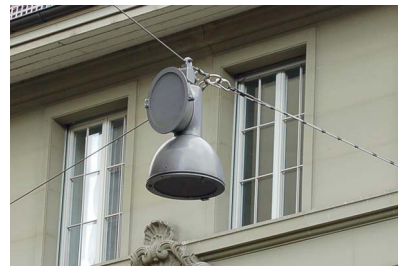
3. Überspannleuchte mit Seitenstrahler
