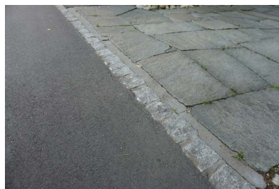
Pflasterstein 14/16 (Trottoir - privates Vorland) ohne Niveauversatz
