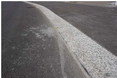
Randstein RN 30 (Anschluss Trottoir) 6cm Versatz
