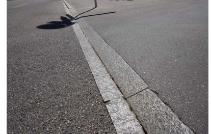
Randstein RN 15 (Überfahrt) schräg gestellt, 4cm, mit Wasserplättli
