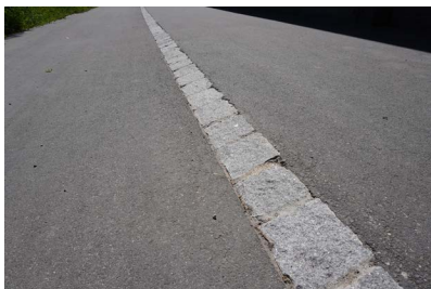
Pflasterstein 14/16 (Trennung Velo - Trottoir) schräg gestellt, 4cm
