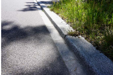
Randstein RN 15 (Anschluss Grünfläche) 6cm Versatz mit Wasserplättli
