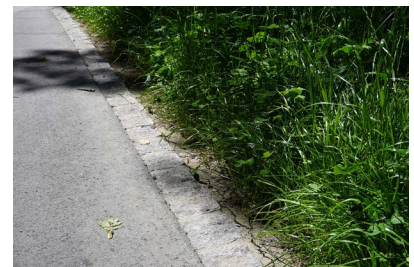
Pflasterstein 11/13 (Grünfläche - Trottoir) ohne Niveauversatz
