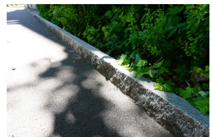
Stellplatte (Übergang private Grünfläche) mit Niveauversatz situativ
