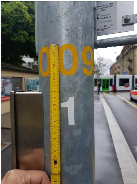
Abbildung 9: Beispiel Ausführung Mastnummerierung inkl. Knotennummer.
