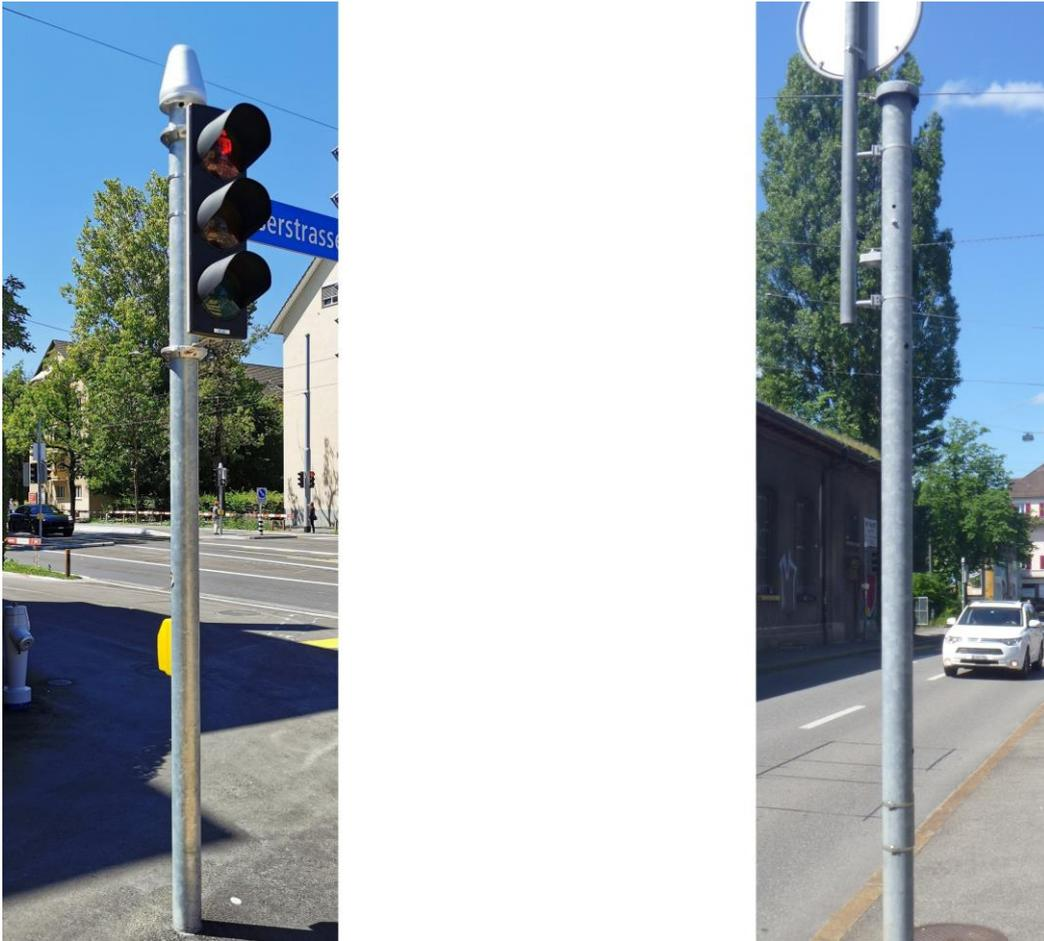
Abbildung 10: Links Mastabschluss via Masthut, rechts Mastabschluss via Mastdeckel.
