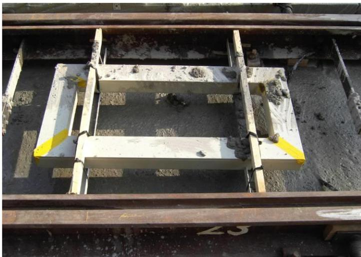
Abbildung 41: Ortungskreis (HFK-Spule) vor dem Betonieren.
