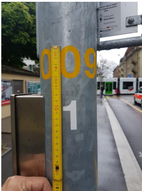
Abbildung 9: Beispiel Ausführung Mastnummerierung inkl. Knotennummer.
