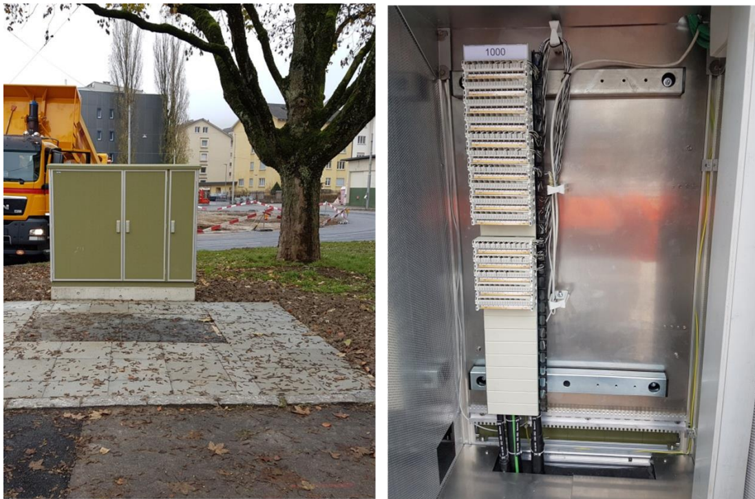
Abbildung 1: Beispielfotos Steuergerätestandort und Anschlussleisten
