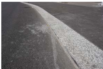
Randstein RN 30 (Anschluss Trottoir) 6cm Versatz
