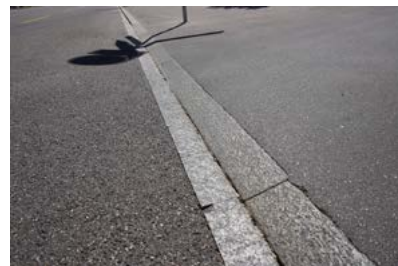
Randstein RN 15 (Überfahrt) schräg gestellt, 4cm, mit Wasserplättli
