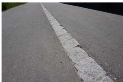
Pflasterstein 14/16 (Trennung Velo - Trottoir) schräg gestellt, 4cm
