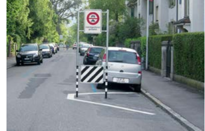
3. Blende 50/70 mit Signalständer
