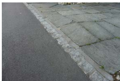
Pflasterstein 14/16 (Trottoir - privates Vorland) ohne Niveauversatz
