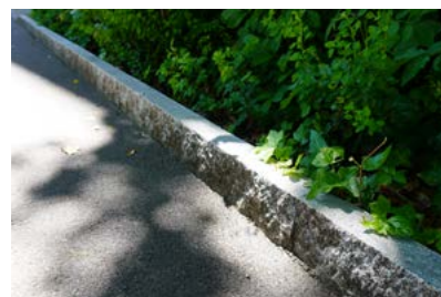
Stellplatte (Übergang private Grünfläche) mit Niveauversatz situativ
