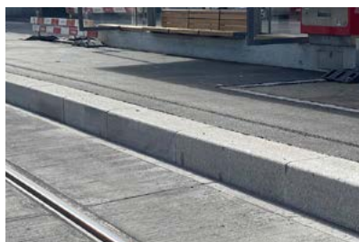
Tramhaltekante, RN 15 / RN 30
