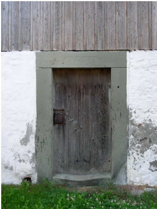
Ausschnitt aus der Fassade des restaurierten Stocks. Foto: Denkmalpflege der Stadt Bern, 2009.
