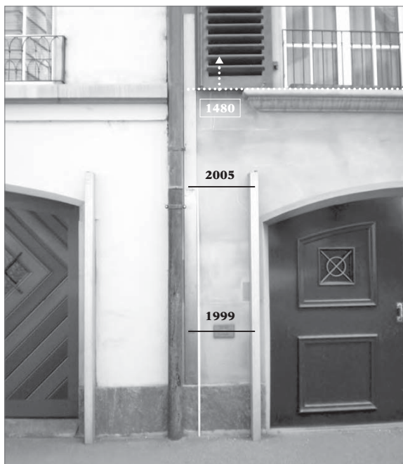
Hochwassermarken Gerbergasse 3/5 Mattenquartier Bern
