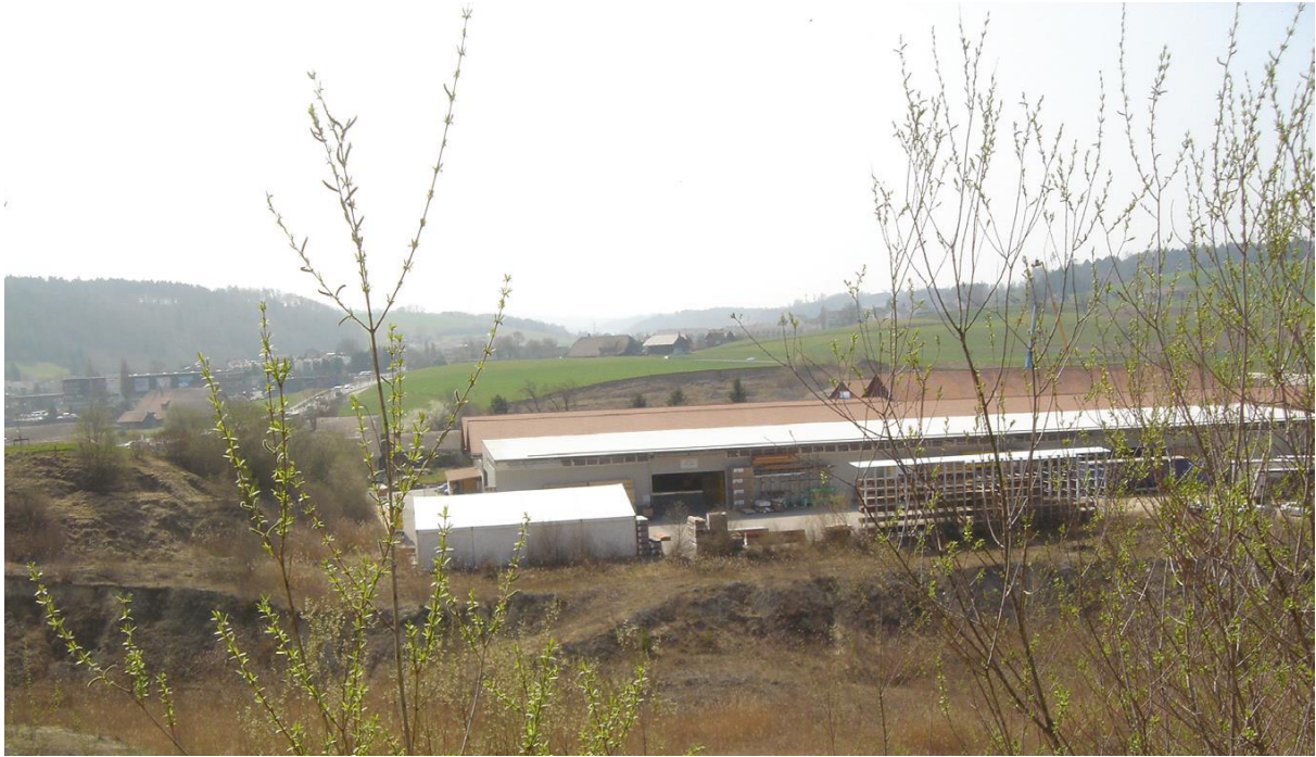
Abbildung 6: Blick von Norden auf das Betriebsareal
