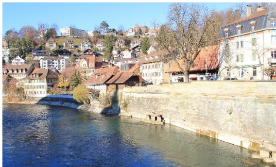
Abbildung 98: Uferverbau; Steinmauer (AB1).
