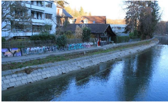
Abbildung 108: Uferverbau; gesetzte Betonquader (AB9).
