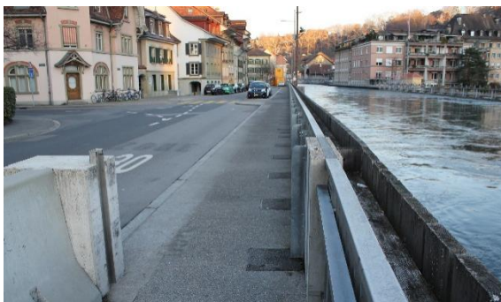
Abbildung 37: Mobiler Hochwasserschutz / mittelfristige Massnahmen entlang Aarstrasse (ML6).
