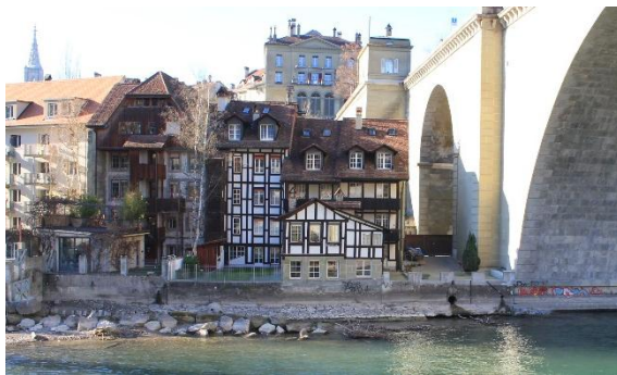
Abbildung 55: Uferverbau; Gehauene und gesetzte Blöcke sowie Betonmauer (ML21).
