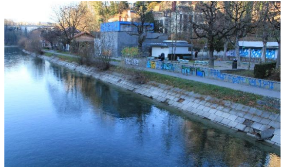
Abbildung 109: Uferverbau; gesetzte Betonquader (AB10).
