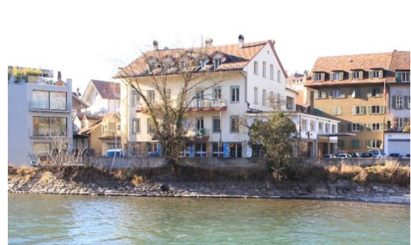
Abbildung 52: Uferverbau; Gehauene und gesetzte Blöcke sowie Betonmauer (ML19).
