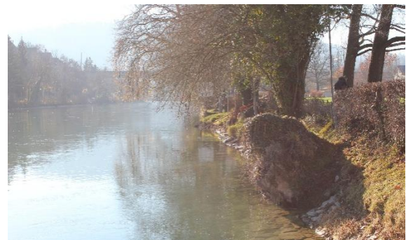
Abbildung 25: Uferverbau; Steine und Ufervegetation (MZ19).
