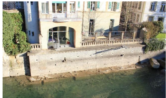
Abbildung 96: Uferverbau; Betonmauer (MR11).
