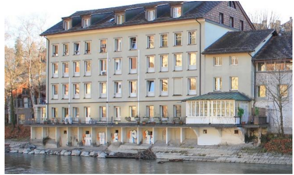
Abbildung 65: Uferverbau; gesetzte Betonquader und Gebäudemauer (LM6).
