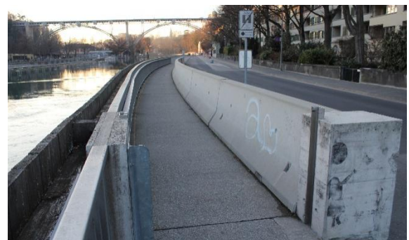
Abbildung 38: Mobiler Hochwasserschutz / mittelfristige Massnahme entlang Aarstrasse (ML7).
