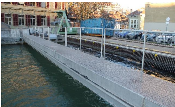
Abbildung 42: Einlaufrechen Wasserkraftwerk (ML10).
