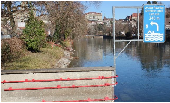
Abbildung 22: Uferverbau; Ausstiegshilfen, Steine und Ufervegetation (MZ17).
