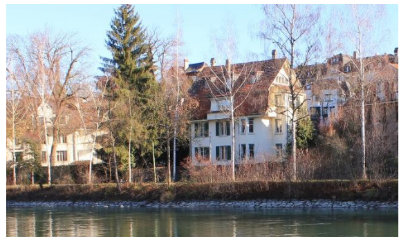
Abbildung 76: Uferverbau; Blocksatz und Ufervegetation (DM6).
