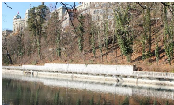
Abbildung 33: Aarstrasse mit hartem Uferverbau aus Beton (ML3).
