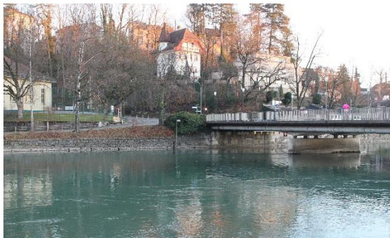
Abbildung 82: Dalmazibrücke und Uferverbau; Steinmauer (MR1).
