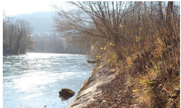
Abbildung 14: Uferverbau; Einbetonierte Steinblöcke und Ufervegetation (MZ10).
