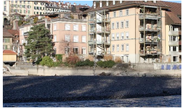
Abbildung 44: Uferverbau; Betonwände (ML12).
