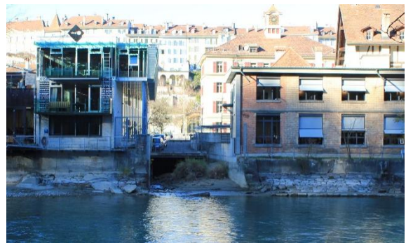
Abbildung 46: Uferverbau; Betonwände und Entlastungskanal Wasserkraftwerk (ML14).
