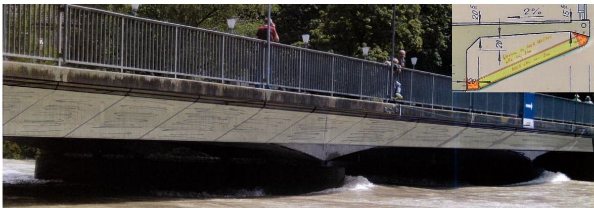
Abbildung 10: Visualisierung Verschalung Dalmazibrücke mit Konzeptskizze.
