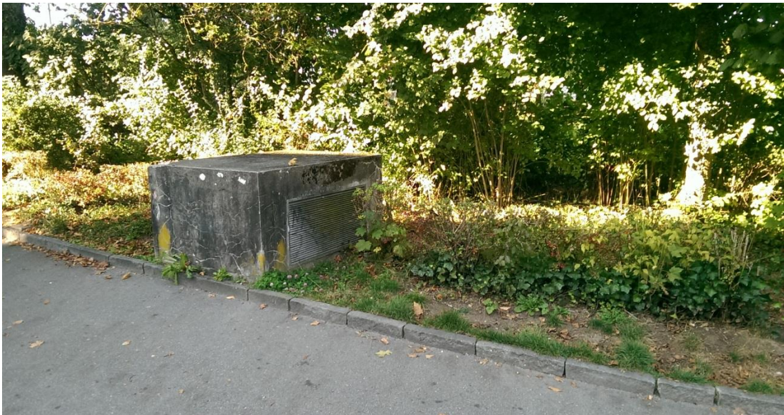
Abbildung 18: Anzupassende Be-/Entlüftung am Sulgenbach (Kreisel Dampfzentrale).
