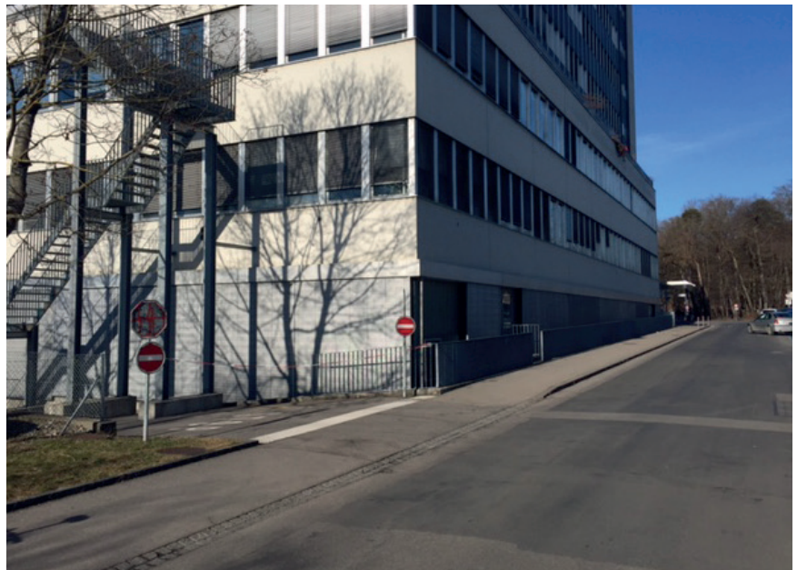
Abbildung: Zufahrtsbereich zur Einstellhalle im Untermattweg heute
