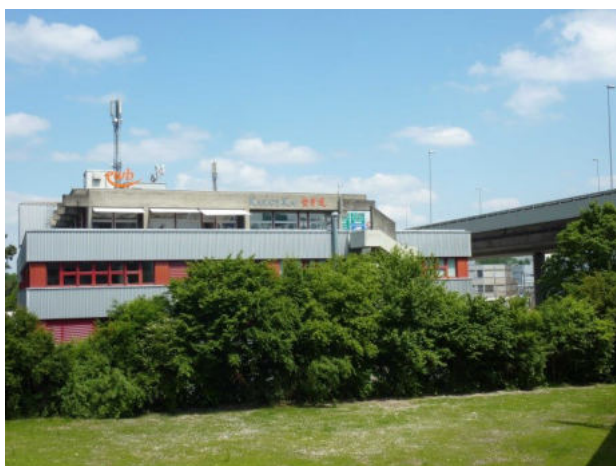
Südfassade Gebäude Stöckackerstrasse 37
