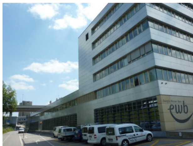
Nord- und Westfassade Gebäude Stöckackerstrasse 33
