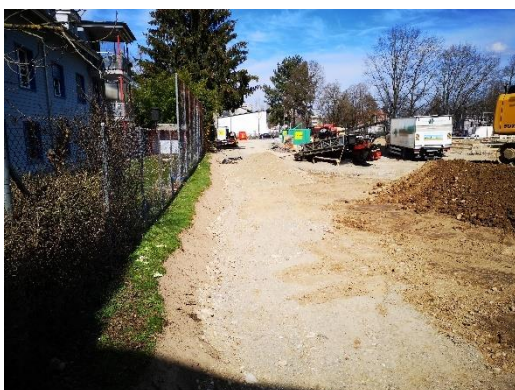
Abbildung 10: Oberboden- und Unterbodenabtrag auf der Parz. 2955. Fotoaufnahme vom 25.03.21
