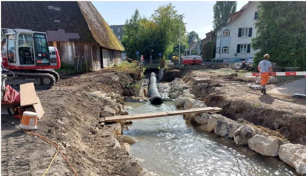
Abbildung 14: Beispielbild Wasserhaltung mit Rohr am Grützbach, Quelle Bild: EWG Derendingen
