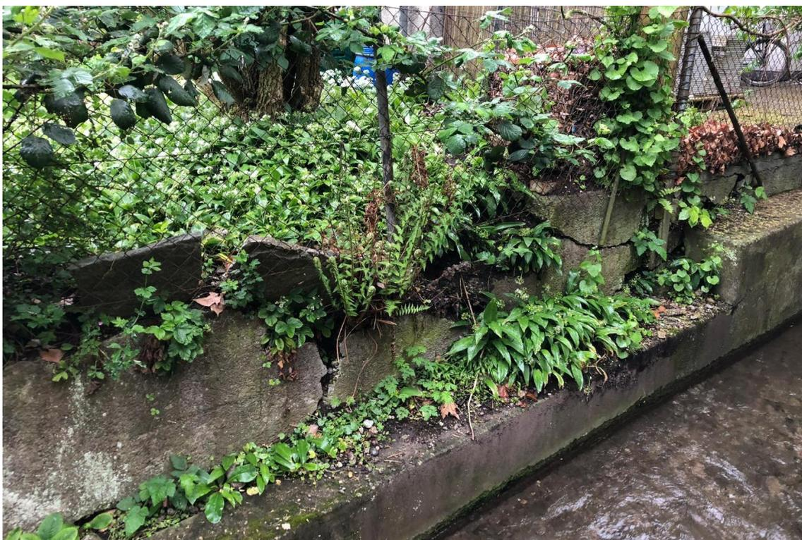
Abbildung 1: Einsturzgefährdete Ufermauer im Projektperimeter, Aufnahme: Juni 2020, K+Z AG
