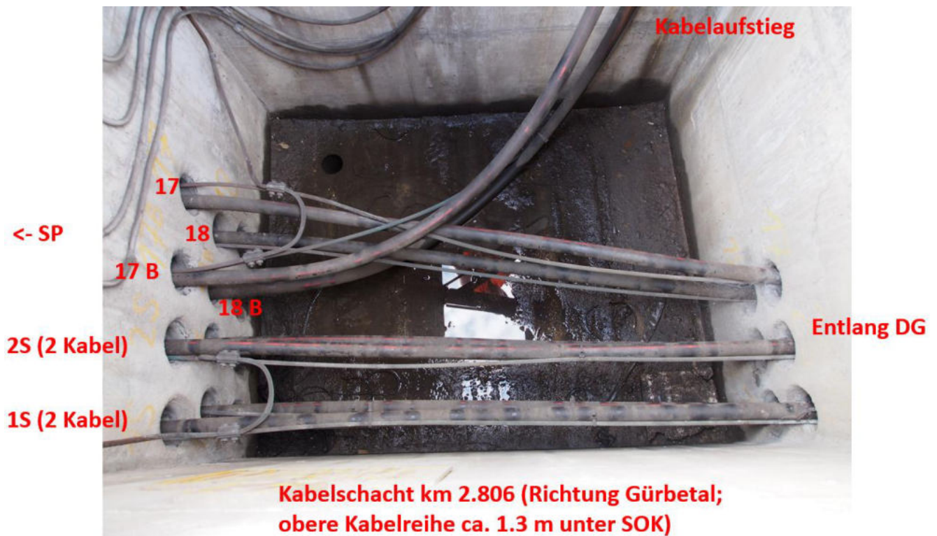
Abbildung 2-4: Anordnung der Kabel und der Rückleiter im Kabelschacht bei km 2.806, unmittelbar beim Kabelaufstieg der Speiseleitungen 17B und 18B.
