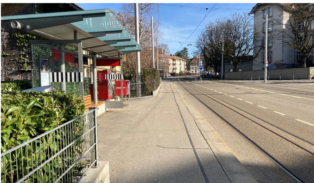
Bestehende Haltestelle / Gehweg
